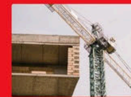
大型クレーン設置
