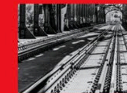
道路・橋梁建設
